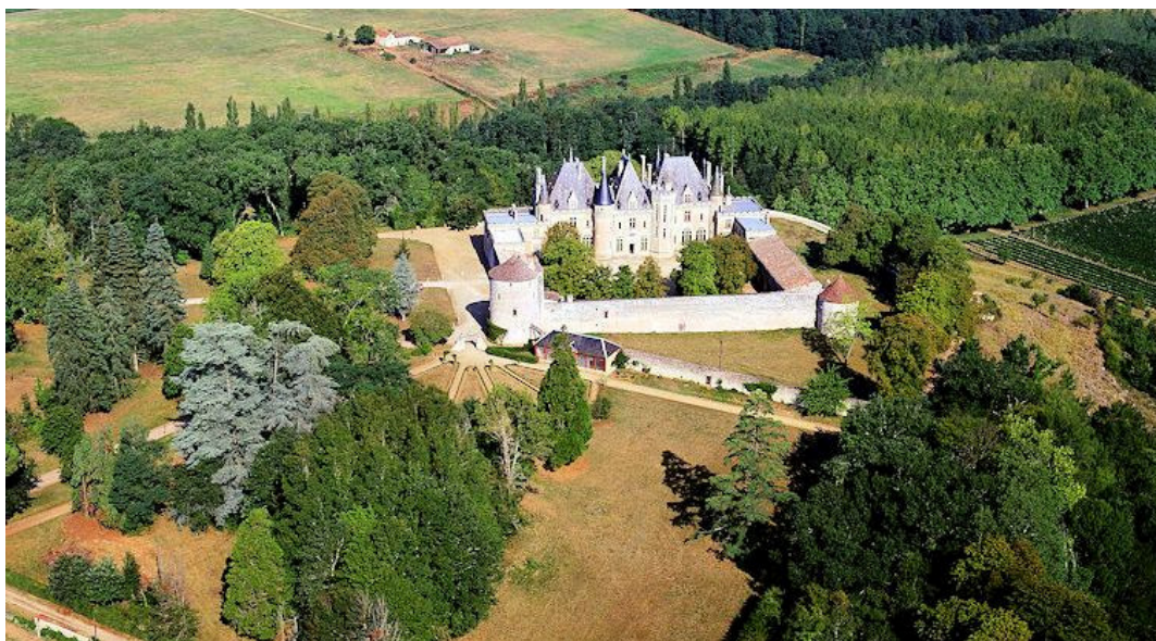
Kasteel, toren en park
