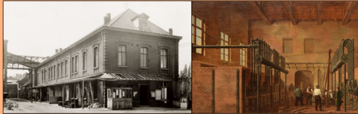
voormalige gasfabriek aan de Gasmeterlaan in Gent / binnenzicht Gents gasfabriek (1830)
